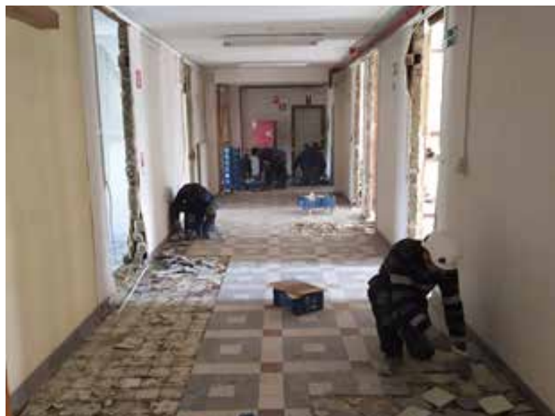
Recupero di massetto idraulico in una demolizione. Fonte: Rotordc www.rotordc.com
